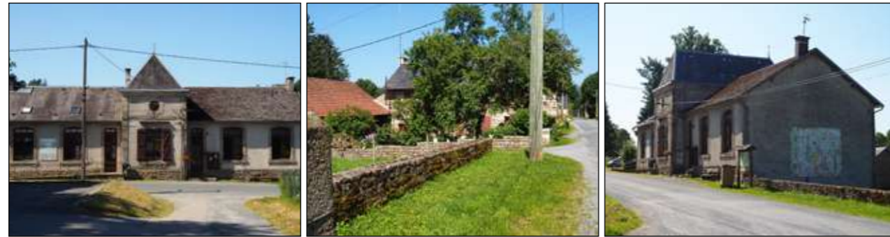
bâtiment de plan rectangulaire allongé. Parfaite symétrie de la façade. rythme des ouvertures le traitement des bords de route enherbé correspond à l'esprit campagnard du village bâtiment implanté à l'alignement. Le pignon est investi depuis l'espace public
