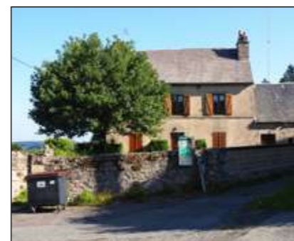
Le muret en pierre offre une belle assise au bâtiment et délimite l'espace privatif
