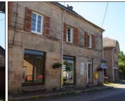
Traitement différencié des menuiseries avec des matériaux contemporains
